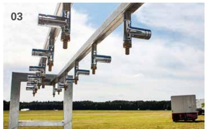
**01** Jede Trinkwasserstation verfügt über zwölf von beiden Seiten zugängliche Abfüllhähne | **02** Die Armaturen sind stabil gearbeitet und verfügen über einen Selbstschlussmechanismus, um unnötigen Wasserverbrauch zu minimieren | **03** Die Trinkwasserstationen können problemlos mit einem Gabelstapler verladen und positioniert werden | **04** Flaschen, Kanister oder ähnliche Behälter lassen sich daran aus einer angenehmen, stehenden Position heraus problemlos und zügig mit Wasser füllen
