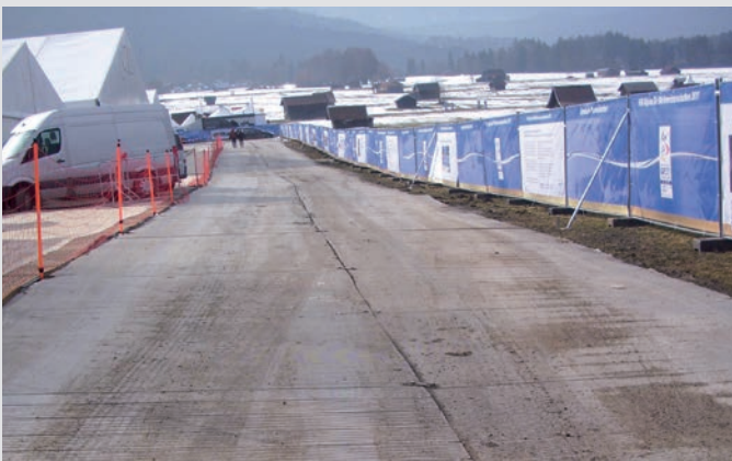
Temporäre Zufahrtsstraße, FIS Alpine Ski WM 2011, Garmisch-Partenkirchen
