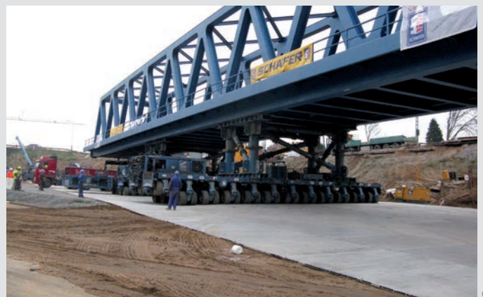
Schwerste Beanspruchung bei Brückenverschub
