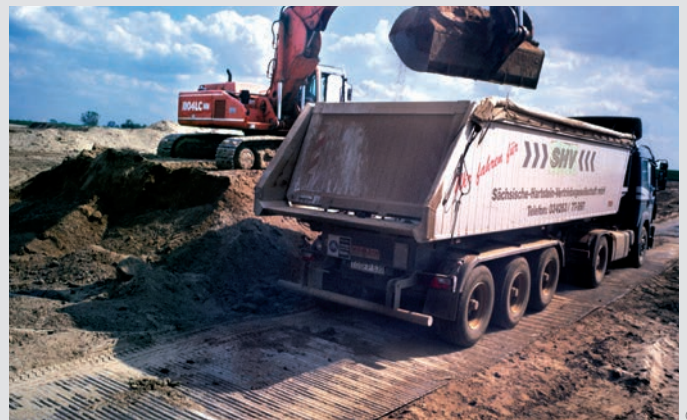
Schwerlaststraße auf einer Baustelle
