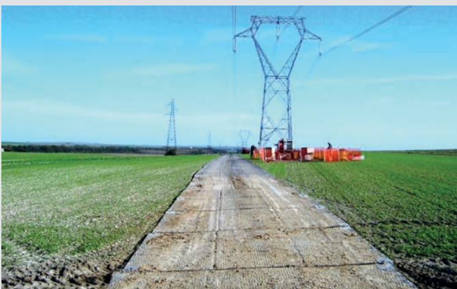
PistEco Baustrasse im Einsatz für den Hochleitungsbau
