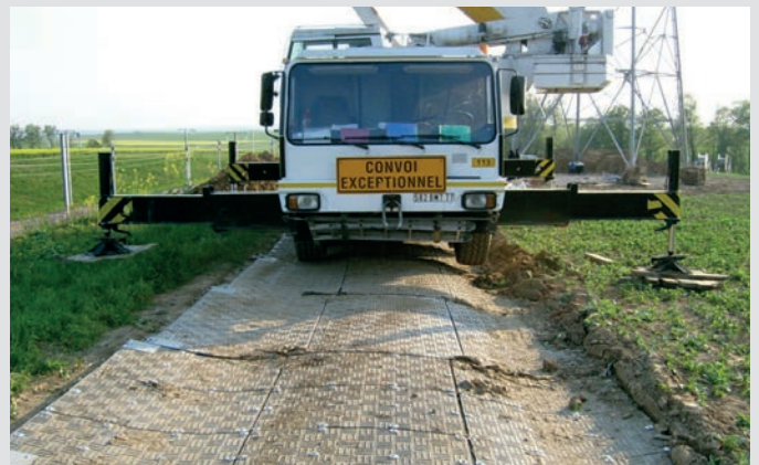
Baustellenzufahrt und Montageplattform in Einem
