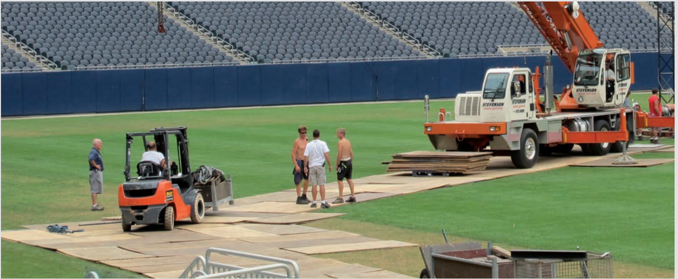
Plywood Platten als temporärer Transportweg
