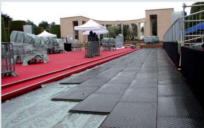
Zusätzlicher Schutz des Untergrundes mit PE-Folie
